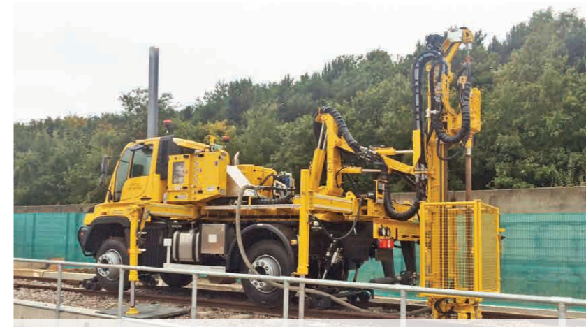
Perforatrice speciale su camion per lavori di consolidamento e sondaggi su tracciati ferroviari Special truck mounted drill rig for investigation works and ground improvement along railway lines.
