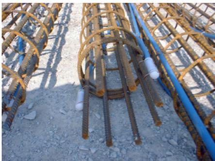
Befestigung von **K Injektionsverpressleitungen**
