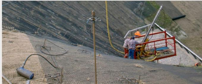
Der **KESA** («Küchler Erdspreizanker») ist der Sofortanker, der zum Einsatz kommt wenn es um Hangsicherungen, Erosionsschutz, Unterstände und Zelte geht. Aber auch bei Traglufthallen, Hohlraumbefestigungen und diversen Befestigungsarbeiten kommt er zum Einsatz. Der **KESA** ist die einfache und schnelle Lösung bei einfachen Verankerungen.
