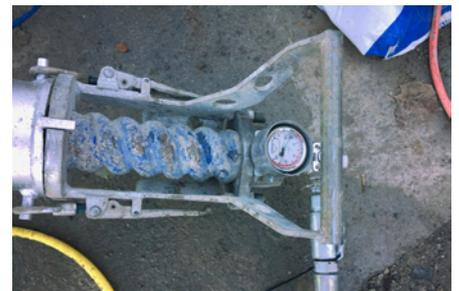
6. Überwachung des inneren Injektionsdrucks.
