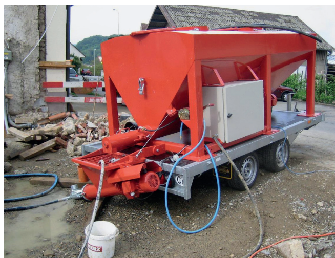
Verfüllung mit «Fräschu»-Siloanhänger
