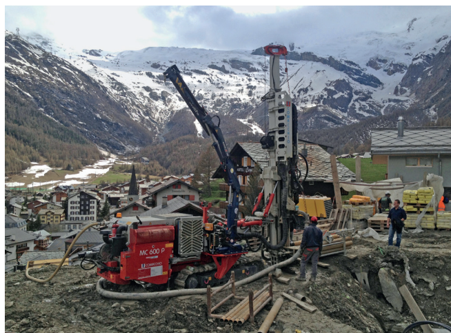
Hinterfüllung von Erdsonden
