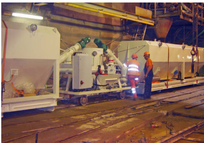
Tunnelbau mit Bahnsilo | 80 t Injektion auf 10 m³/h
