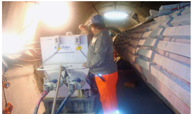
Stollenbau mit mengenregulierter Doppel-MUNG-Pumpe
