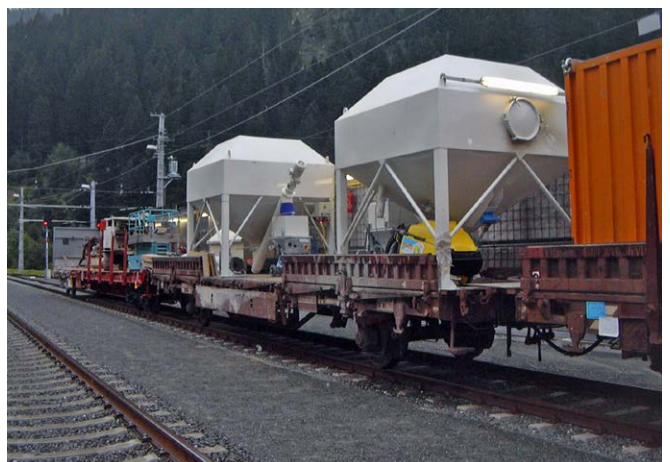
Tunnelbau mit Bahnsilo
