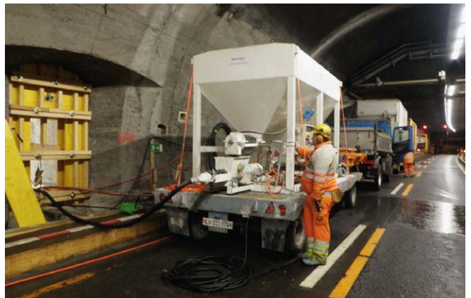
Tunnelbau mit Fräschu
