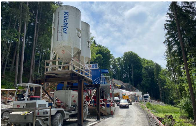
Tunnelbau mit Silo-Ausseninstallation
