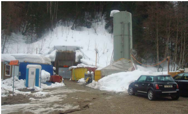
Stollenbau mit Ausseninstallation 3 000 m Pumpenleistung
