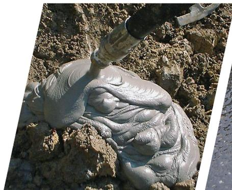
Remplissage avec mortier, ciment ou KÜMIX®
