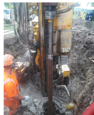
Micropieux 38/76 à Teufen, env. 350 mètres linéaires
