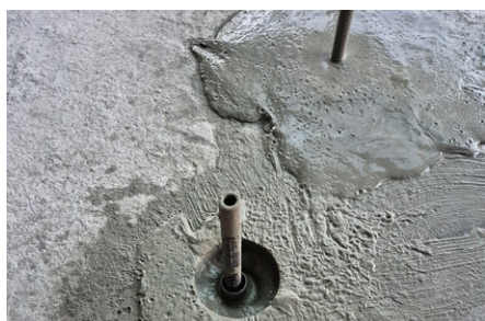
7. Système KÜPS ® entièrement injecté et incorporé..
