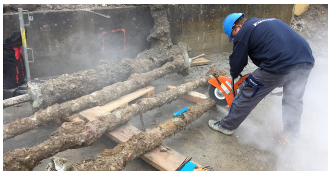
Trois ancrages KÜPS® testés. 6 coupes au niveau de chaque manchon.
