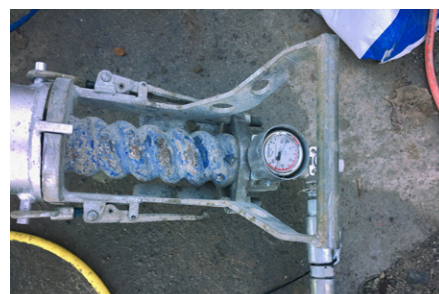
6. Surveillance de la pression d'injection intérieure.
