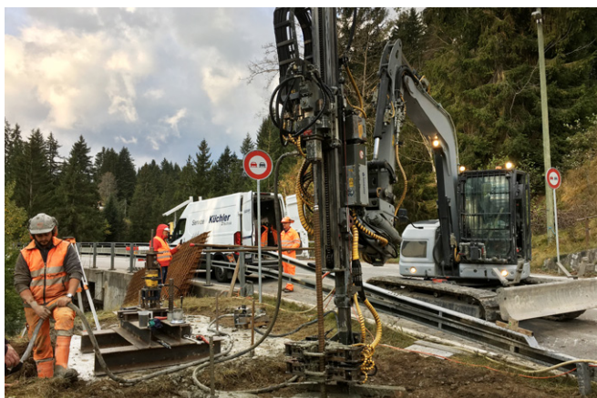
Forages d'essai à Zweisimmen, Oberland bernois.
