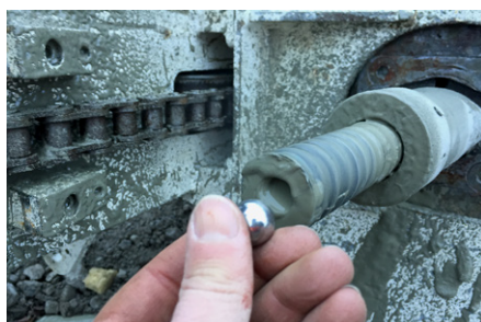
5. Atteinte de la longueur d'ancrage; Désaccoupler du marteau de forage, retirer l'adaptateur amortisseur de frappe, monter l'adaptateur d'injection, introduire la bille dans la barre d'ancrage KSB ® puis injecter l'espace annulaire intérieur avec le KÜMIX ® via la valve d'injection située au niveau de la couronne. Lors de la sortie de l'adaptateur d'injection, la sortie est fermée au moyen du robinet à bille et l'étanchéité de l'espace annulaire intérieur est contrôlée à 2 bars.
