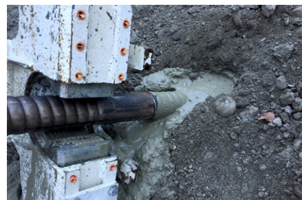
3. Rallonge du KÜPS ®; Rallonge libre permettant une adaptation optimale aux conditions géologiques. Désaccoupler du marteau de forage.
