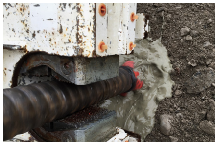
2. Pomper le KÜMIX ® au travers du KÜPS ® via la tête d'injection depuis la couronne. Forage avec circulation continue du KÜMIX ®.
