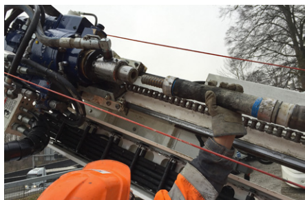
1. Accoupler le KÜPS ® au marteau de forage.
