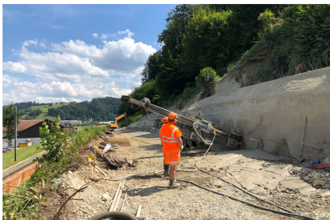
Pareil clouée 32/60 à Gettnau (BLS), env. 1000 mètres linéaires.
