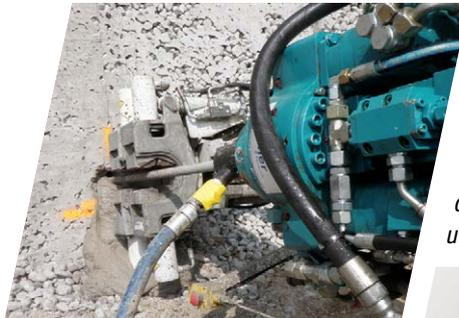
Mithilfe des KSB® Spülkopfs kann während des Bohrvorgangs Zementmörtel durch den Hohlraum eines rotierenden Ankers gepumpt werden. Auf diese unkomplizierte Weise wird gewährleistet, dass während des Bohrfortschritts eine gleichzeitige Injektion des Hohlankers erfolgt. Der Injektionsadapter besteht aus drei Komponenten – der Spülkopfwelle, dem Spülkopf und dem Dichtungssatz.
