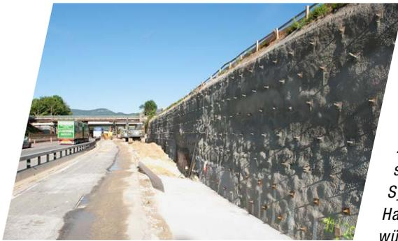
Bodenvernagelungen sollten in einem romben-förmigen Raster geplant werden, um eine effiziente Verteilung der Bewehrung sicherzustellen. Innerhalb der vernagelten Front sollte man ein entsprechendes Drainage System sicherstellen, dass sich innerhalb des Hangs kein Wasser sammeln kann. Dieses würde später eine unkontrollierte Belastung auf die Vorsatzschale ausüben.
