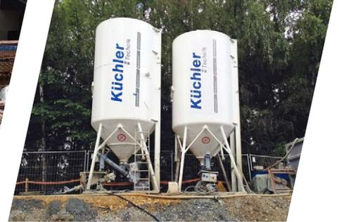
Als Injektionsgut empfehlen wir KÜMIX®. Dieser überzeugt im Vergleich mit herkömmlichen Zementen durch seine hohe Früh- und Endfestigkeit. Daneben ist er thixotrop, was für die Verarbeitung als Injektionsgut von wesentlichem Vorteil ist. Weiter ist er Sulfat beständig und schwindarm.
