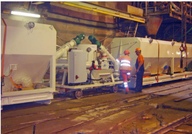
Construction de tunnel avec silo sur rail | Injections de 80 t à 10 m<sup>3</sup>/h
