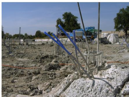
Pieu en béton avec quatre **K Conduites** d'injection placées à deux profondeurs différentes
