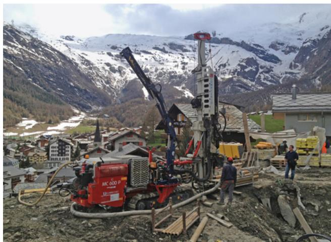
Remblayage de sondes géothermiques
