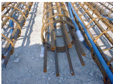
Fixation des **K Conduites** d'injection sous pression
