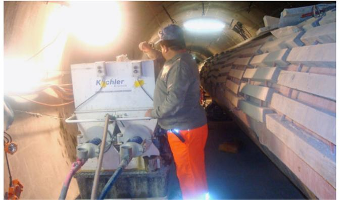
Construction de galerie avec double pompe MUNG à régulation de quantité
