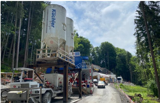
Construction de tunnel avec installation de silo extérieure
