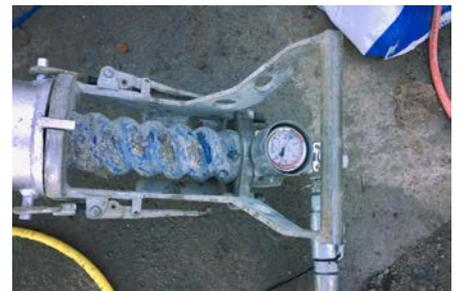
6. Überwachung des inneren Injektionsdrucks.
